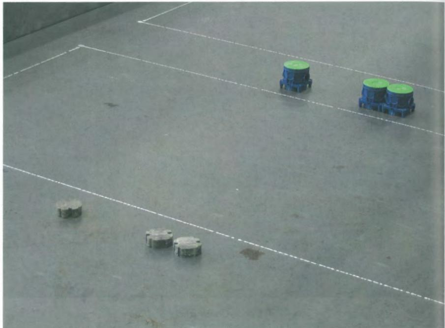
Automatisch gesetzte Elektrodosenmagnete
