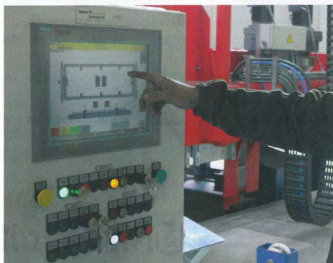
Steuerstelle zur Bedienung eines Wendegerätes
